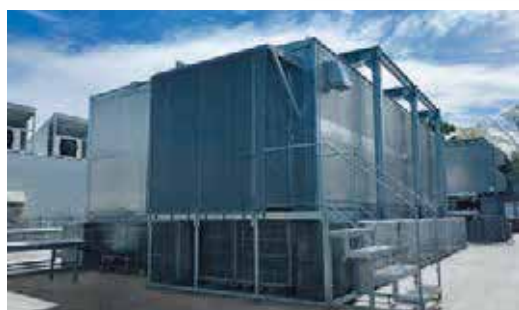
コンテナ型データセンター外観
