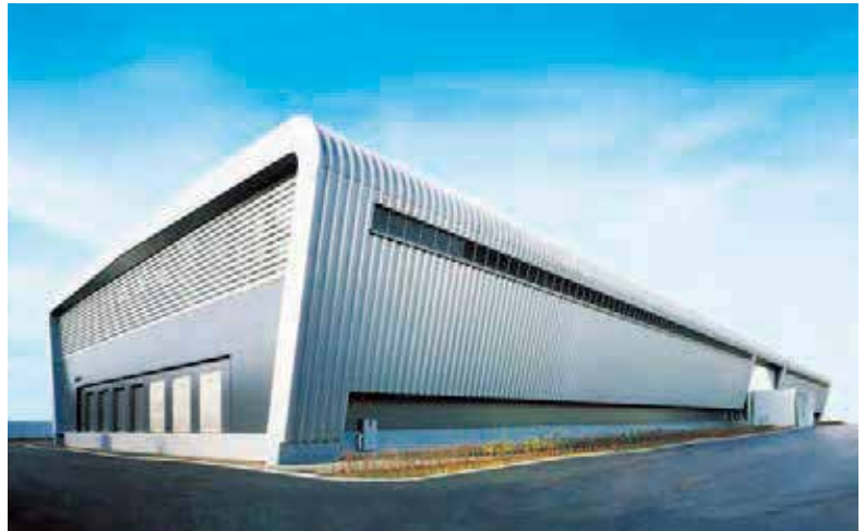
石狩データセンター1・2号棟
