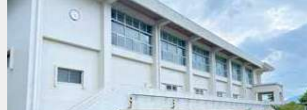
香川県綾川町データセンター 廃校を活用し、計算力を高める
