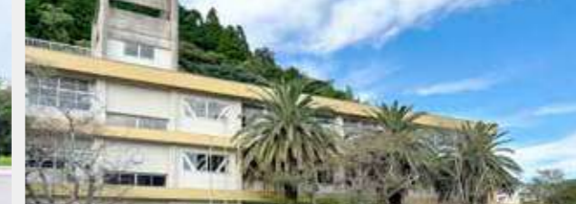
佐賀県玄海町データセンター 廃校を活用した志賀DCのGPU分散拠点
