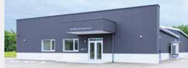
石川県志賀町データセンター エアコン×外気冷却のハイブリッド設計
