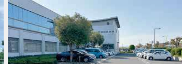
香川県高松市データセンター 未活用研究施設に新たな価値を創出
