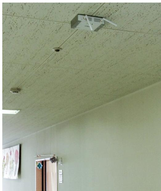
図 2: Wi-Fi アンテナの設置例
