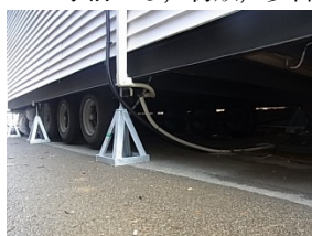
b. トレーラハウス底部
