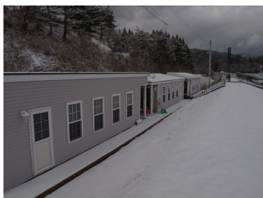
a. コンソーシアムで設置した3台のトレーラハウス群。手前から、物販、多目的、支援拠点トレーラハウス。
