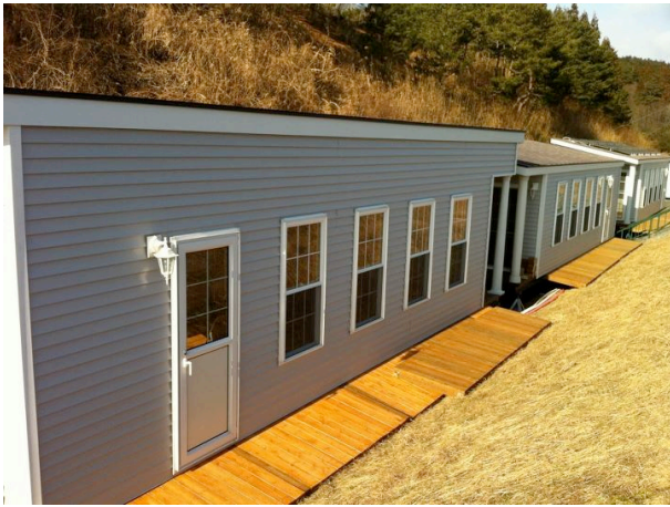
図1 仮設住宅脇に設置されたトレーラーハウス
