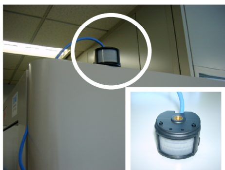
図4 赤外線モーションセンサ設置状況
